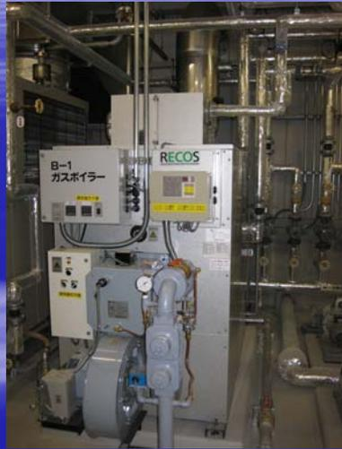
機械室の潜熱回収型ガスボイラー
