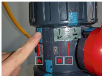
C点の位置の時、0.35MPaでは漏水しないが、減圧すると少量の漏水が発生
